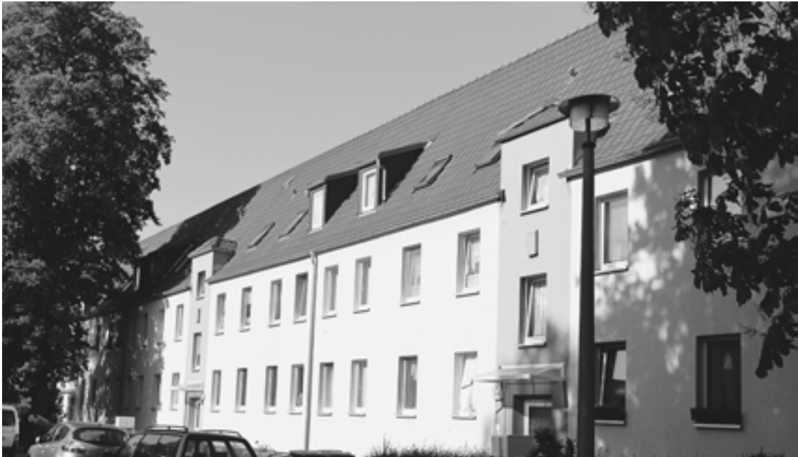
Wohnanlage in der Stadt Borna bei Leipzig, 183 Wohnungen verteilen sich auf drei Straßenzüge. Die gesamte Wohnanlage umfasst ca. 10.000 m 2 Wohnfläche.
